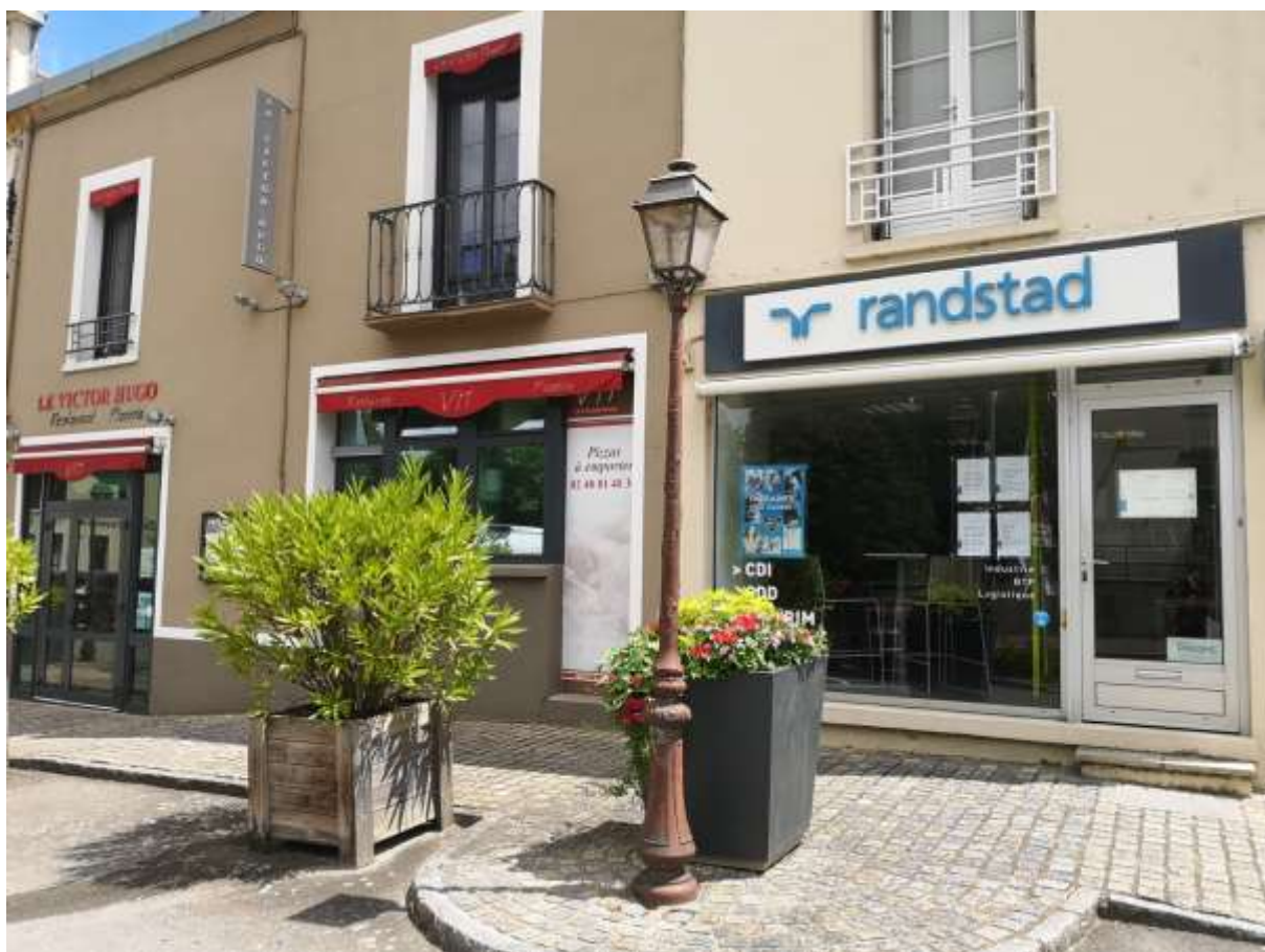
Enseignes bien intégrées à la devanture commerciale, installées dans les limites du rez-de-chaussée, Châteaubriant, juillet 2019.
