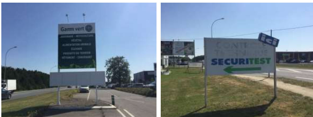
Enseigne scellée au sol ou installée directement sur le sol dont la hauteur excède 6,5m et dispositif en mauvais état d'entretien, Châteaubriant, juillet 2019.
