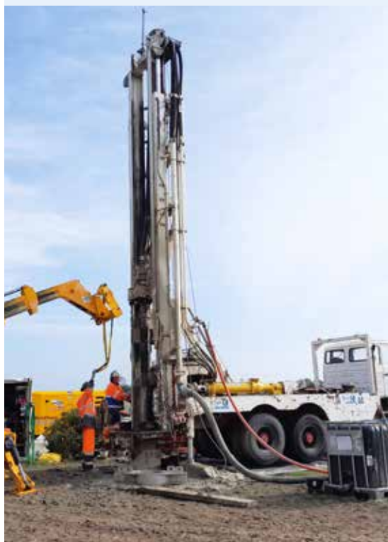
Nouveau forage à Massérac
