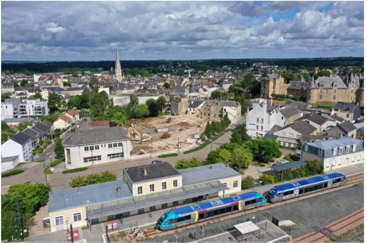
Vue du ciel – Démolitions Ilot des Terrasses
