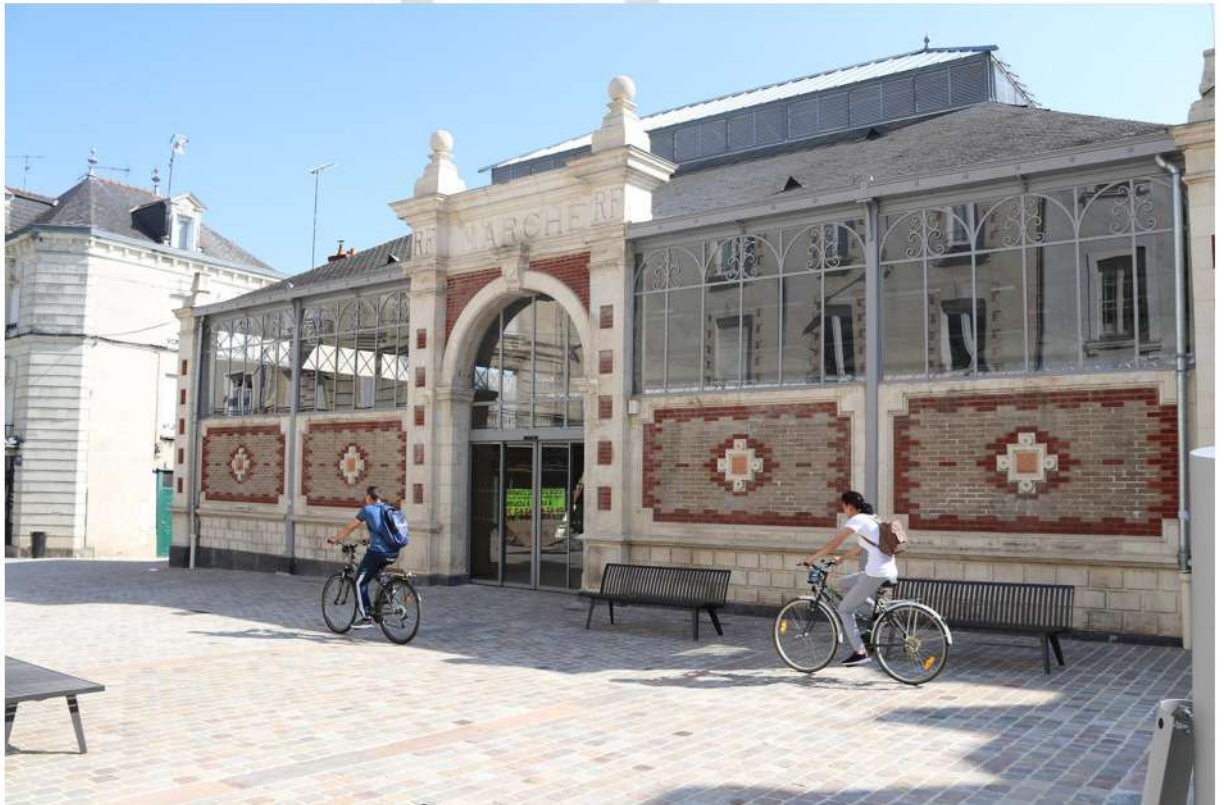
Vue sur le marché couvert rénové
