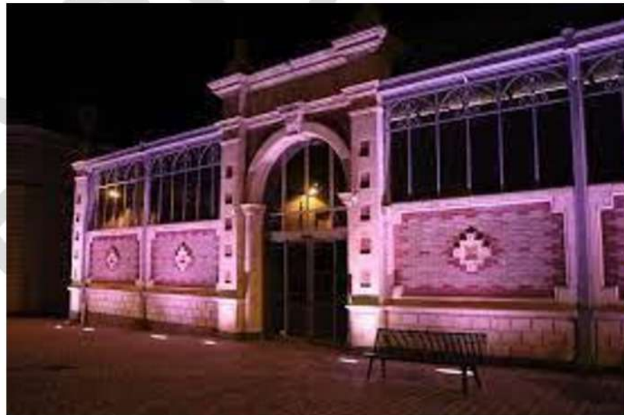
Photo mise ne lumière du marché couvert
