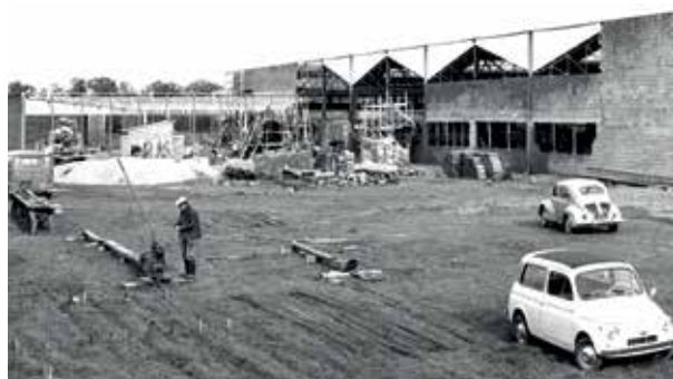
1962 : construction de l'usine ALCA, aujourd'hui Tetra Pak.
