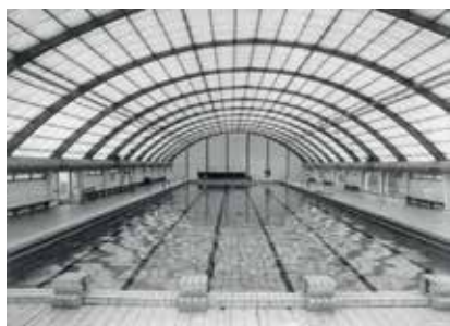
Construction dans les années 1970 du bassin olympique de 50 mètres (6 lignes d'eau) aujourd'hui Espace Dauphins.
